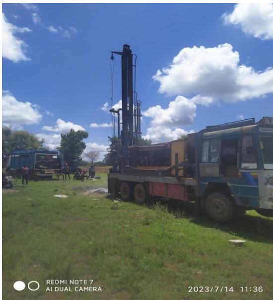
L'atelier de foration installé
