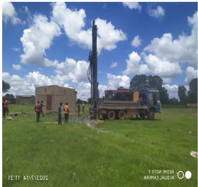
L'atelier de foration installé
