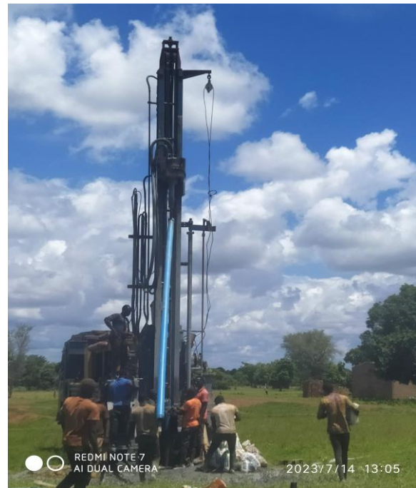
Equipement du forage en tubes PVC et protection des parois du forage avec du sable lavé
