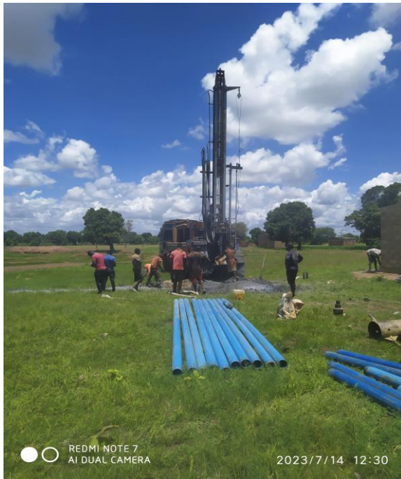
Equipement du forage en tubes PVC et protection des parois du forage avec du sable lavé
